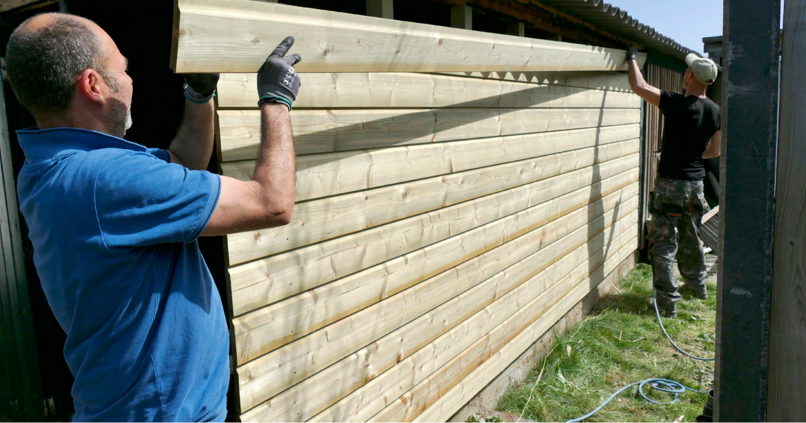
Maatwerkschuurtjes met kadastrale afwijkingen ter plaatse opnieuw gebouwd om ongemak voor bewoners te beperken - opdrachtgever Waardwonen
